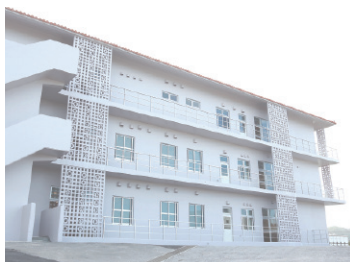
新たに建設されたクロザピン治療病棟
